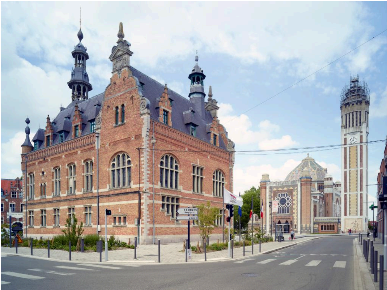
Vue d'ensemble depuis ouest.
