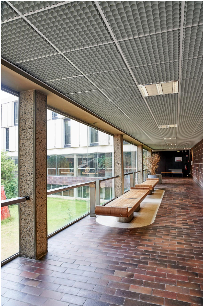
Espaces de circulation du rez-de-chaussée haut donnant sur le patio.
