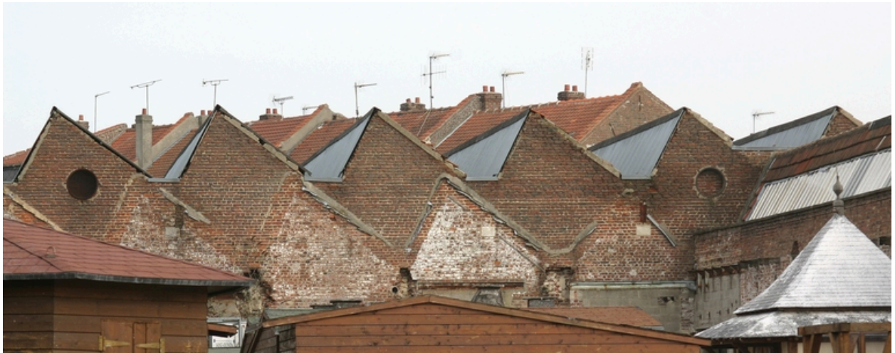
Détail des sheds des ateliers de 1921.
