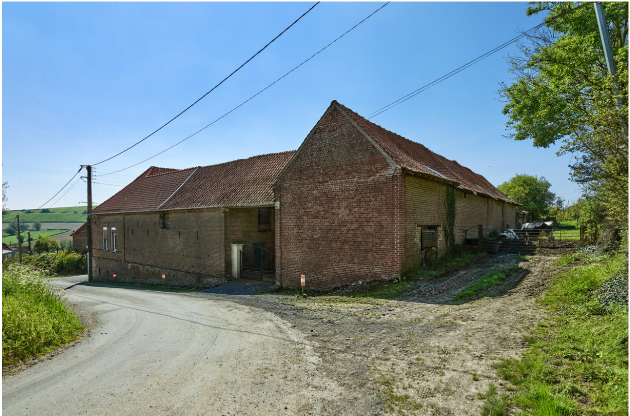
Vue générale depuis le nord.
