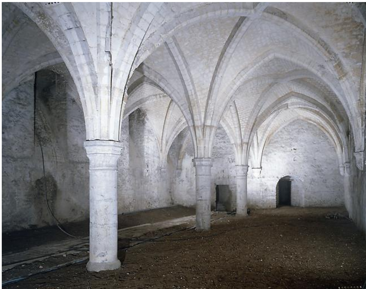
Salle "la Barbière", vue vers couloir de distribution.
