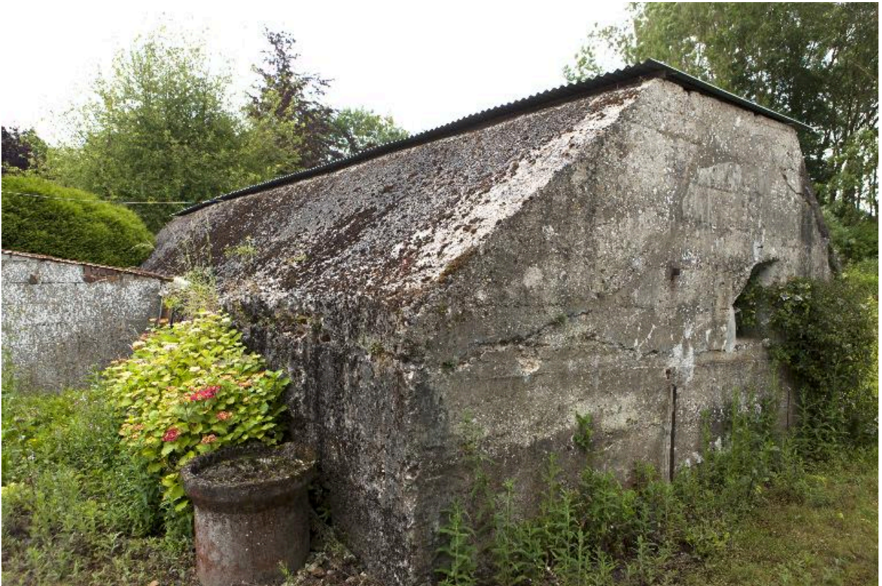
Vue de trois-quarts vers le sud-est. L'élévation nord et le pignon ouest
