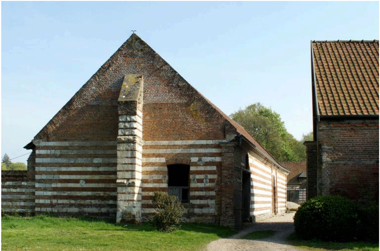
Mur-pignon et contrefort extérieurs de la grange.
