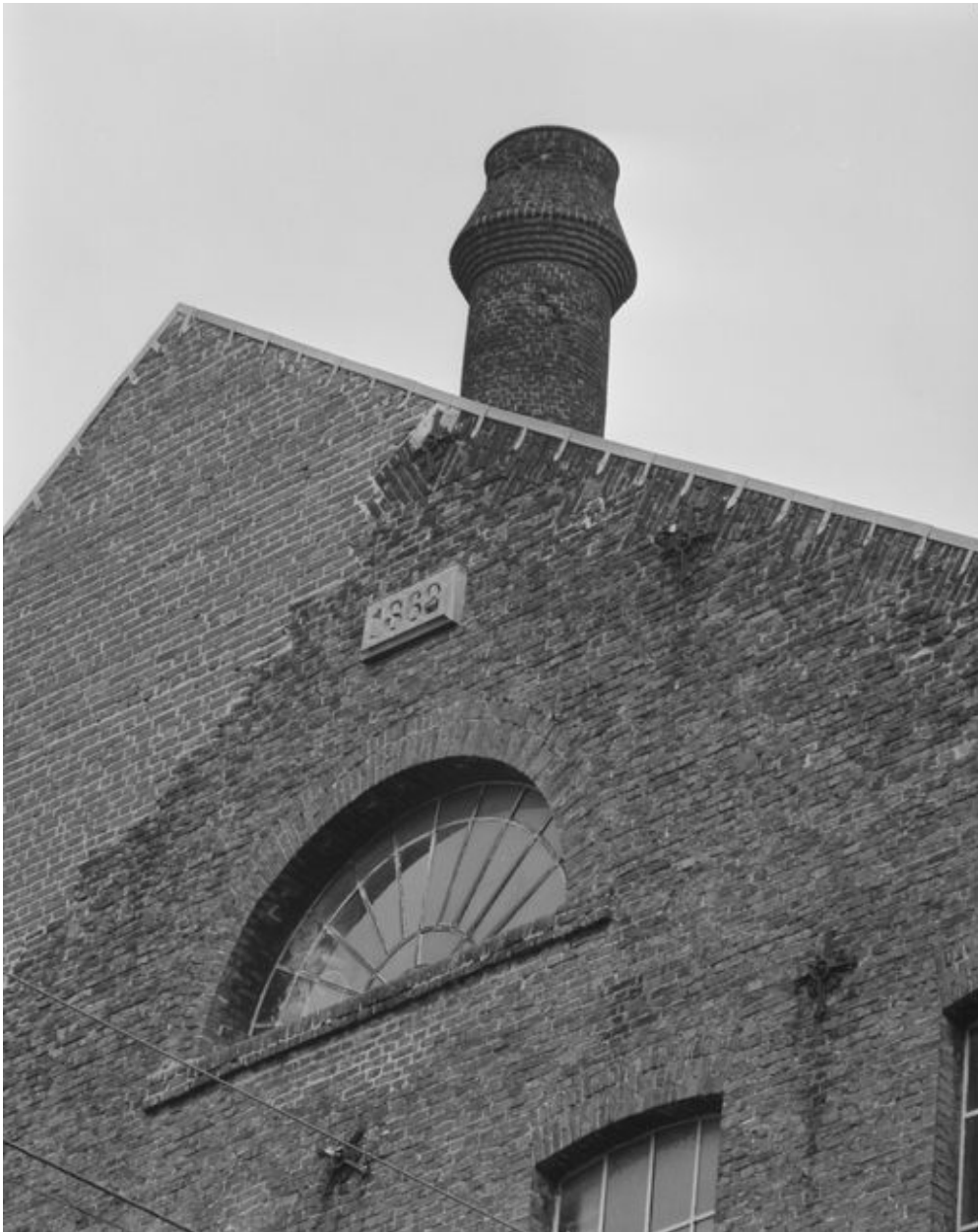
Pignon ouest, vue de détail (date portée).
