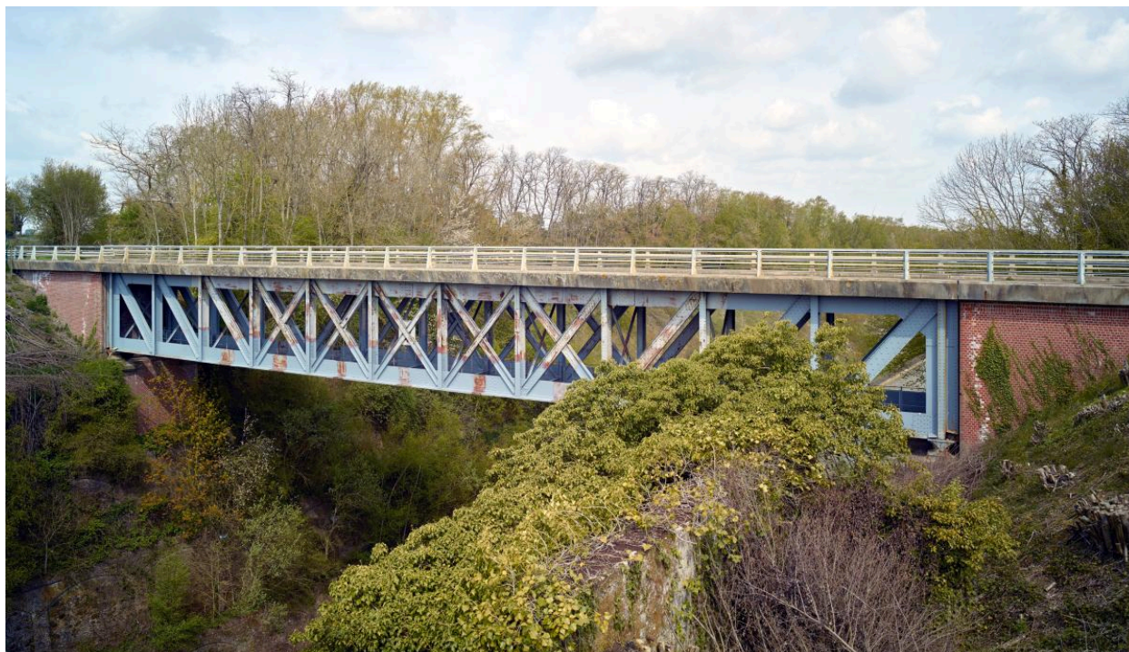
Pont routier nord.
