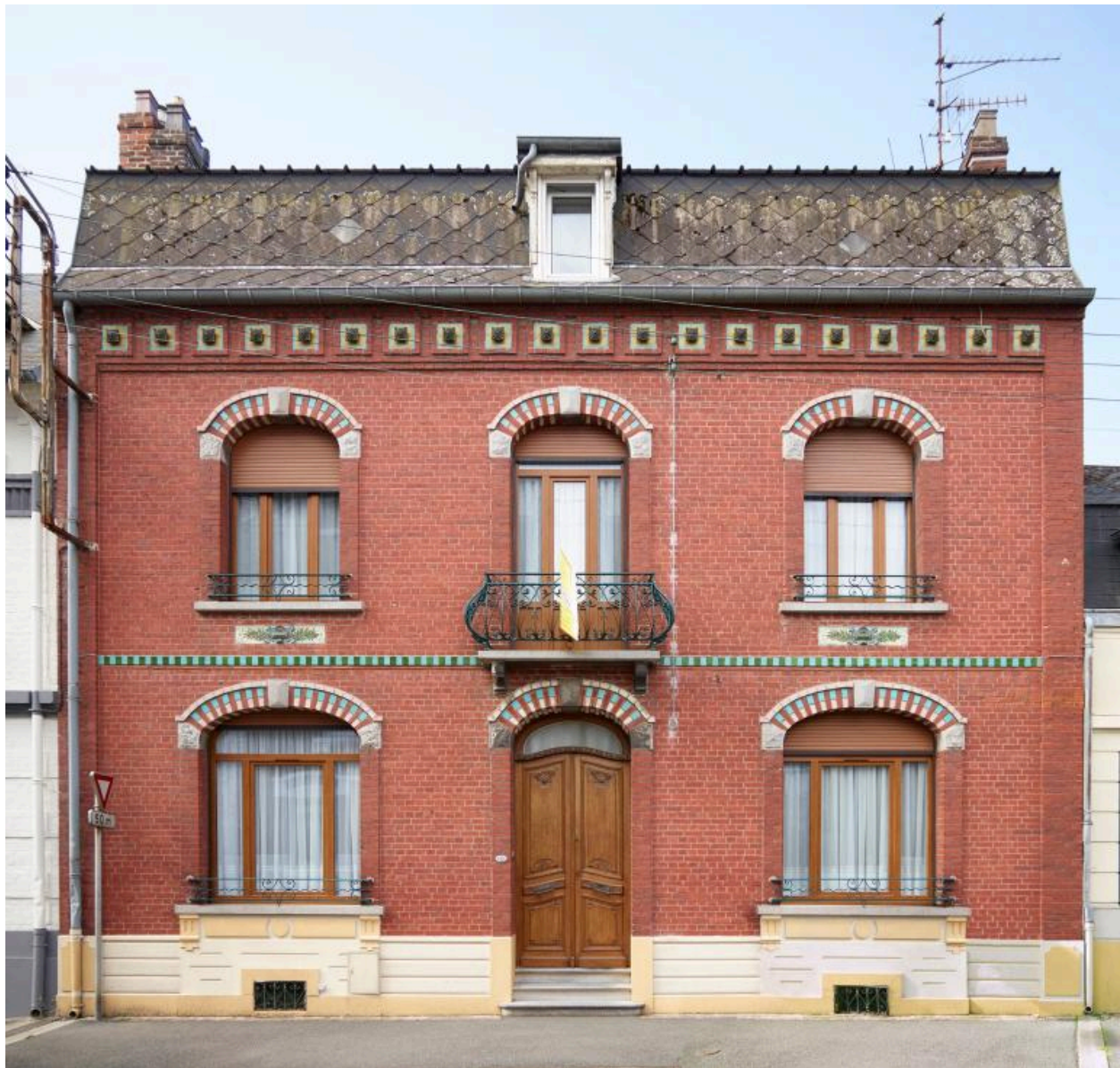
Maison, n°8 rue Leconte. Façade principale depuis la rue. Décors de briques vernissées, de plaques émaillées et de cabochons émaillés.
