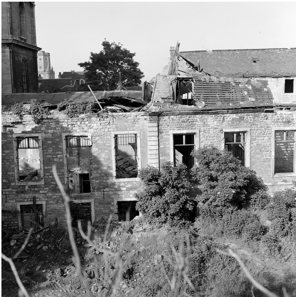
Bâtiment F, façade nord-est sur rempart, partie centrale, au deuxième plan, bâtiment E.
