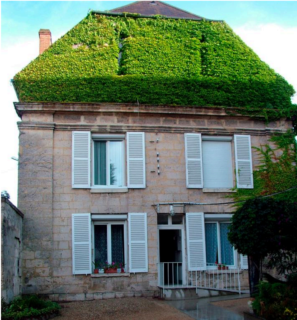
Vue du pignon d'un pavillon annexe.
