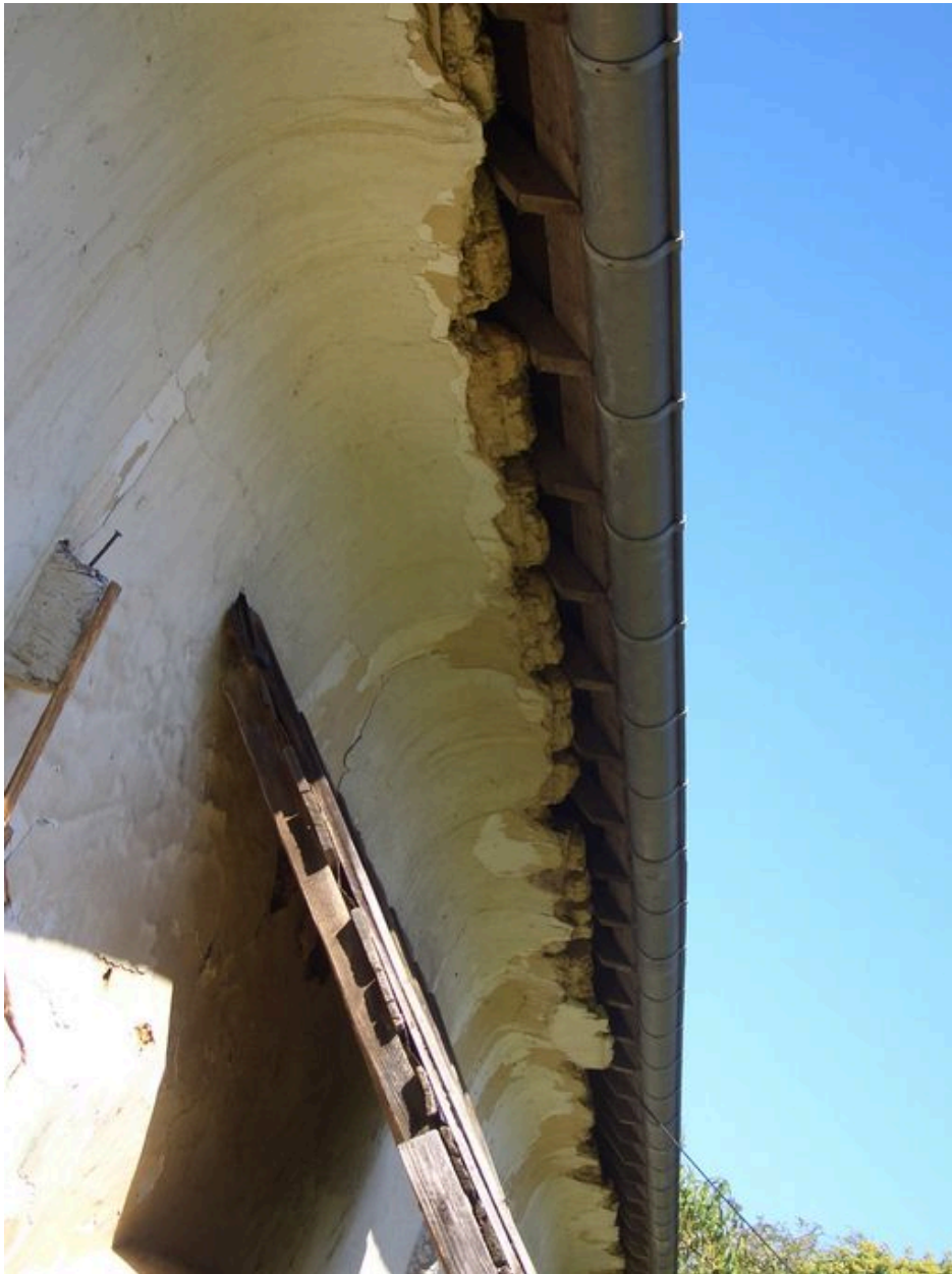
Vue de la corniche arrondie, dite voûte.
