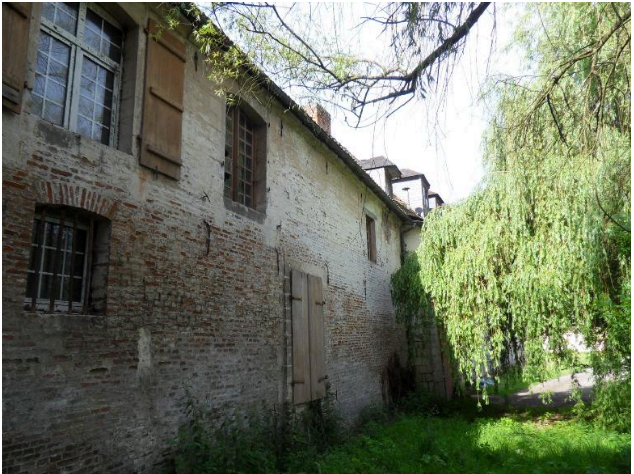
Vue du mur nord de la partie est du logis.
