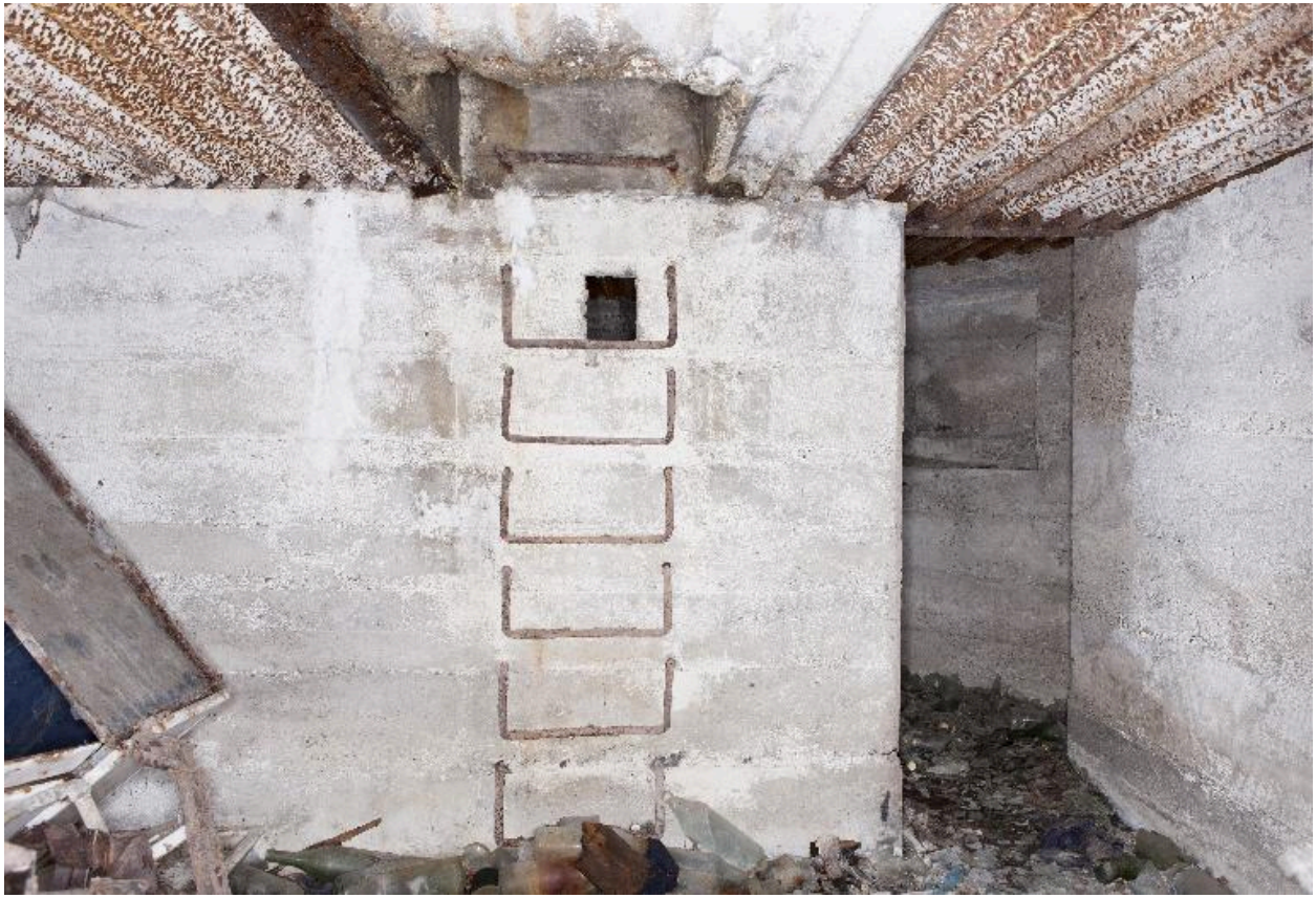
Casemate nord. Première salle rectangulaire avec, au centre, échelons métalliques menant à l'observatoire cuirassé
