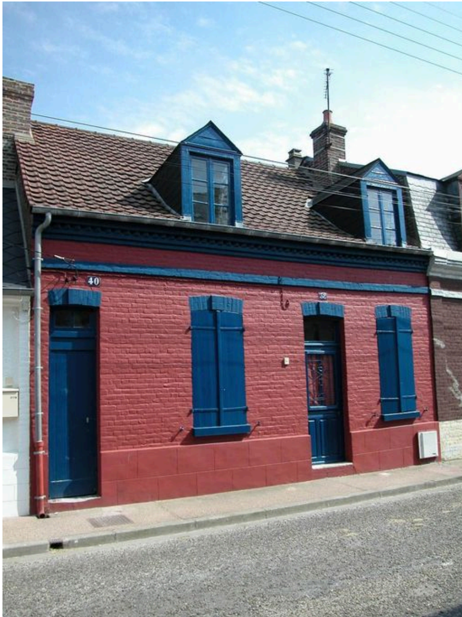
Maison de pêcheur à deux logements, 38 et 40 rue de la Prison-Jeanne-d'Arc.
