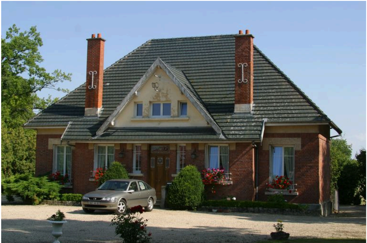
Vue sur cour du logement du gardien.
