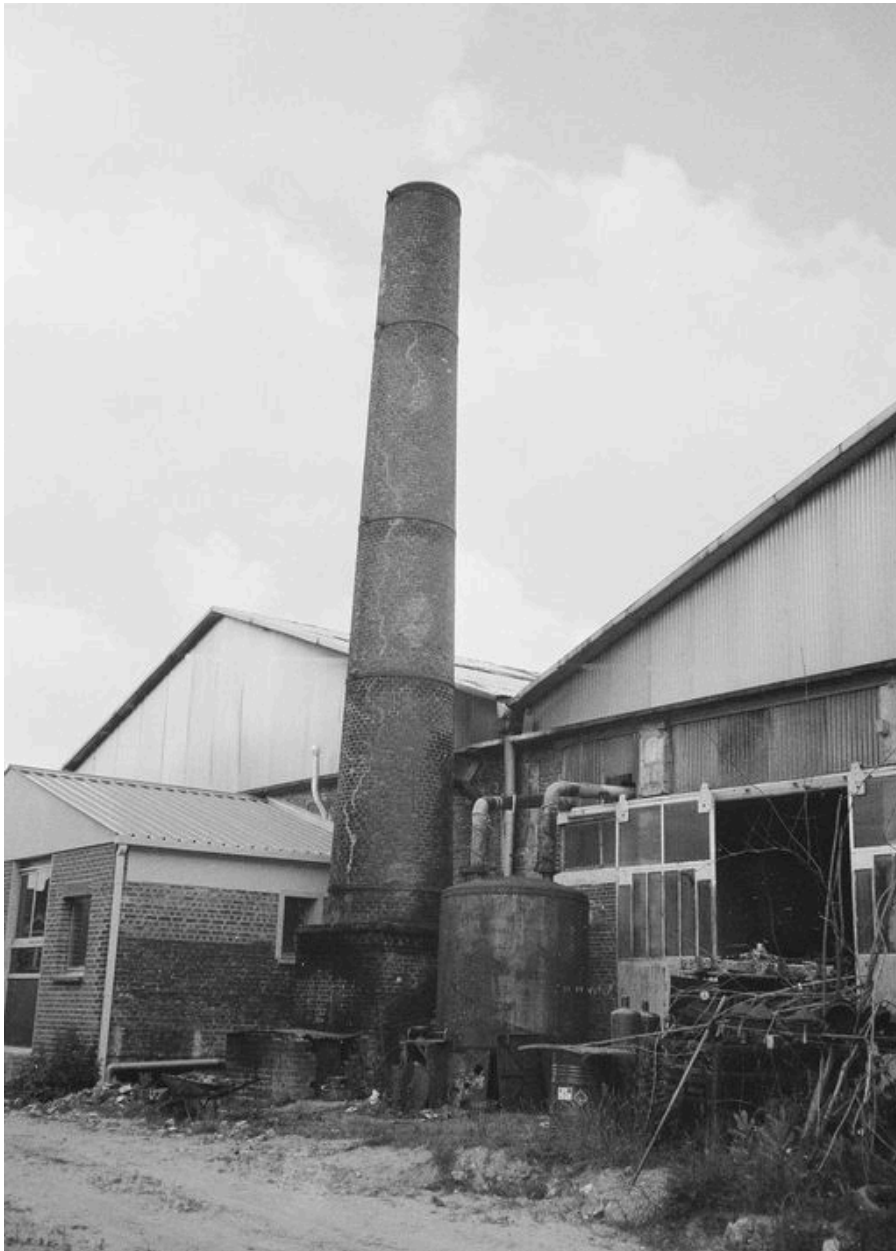
Atelier de fabrication, flanc est.
