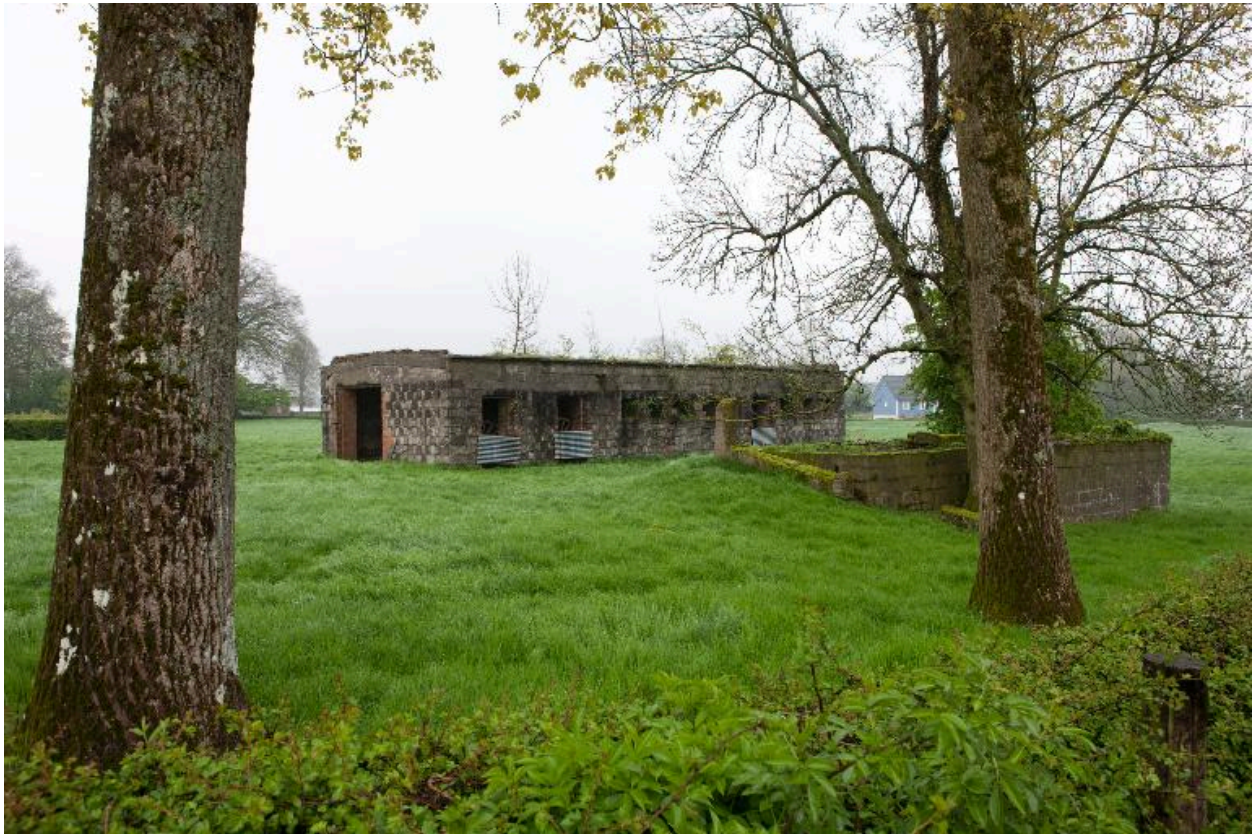
Vue d'ensemble du bâtiment de montage (à gauche) et du bâtiment de stockage des réactifs chimiques (à droite).
