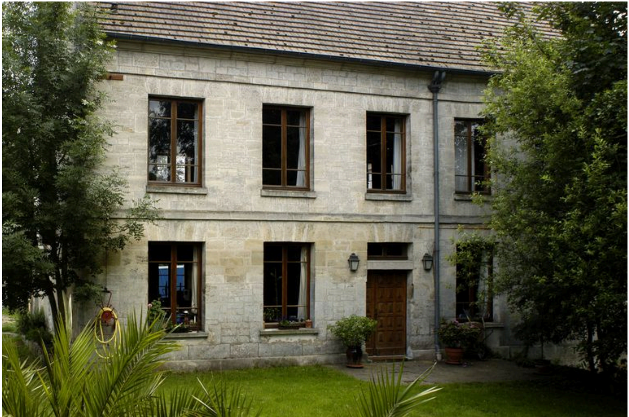
Façade postérieure de la filature.
