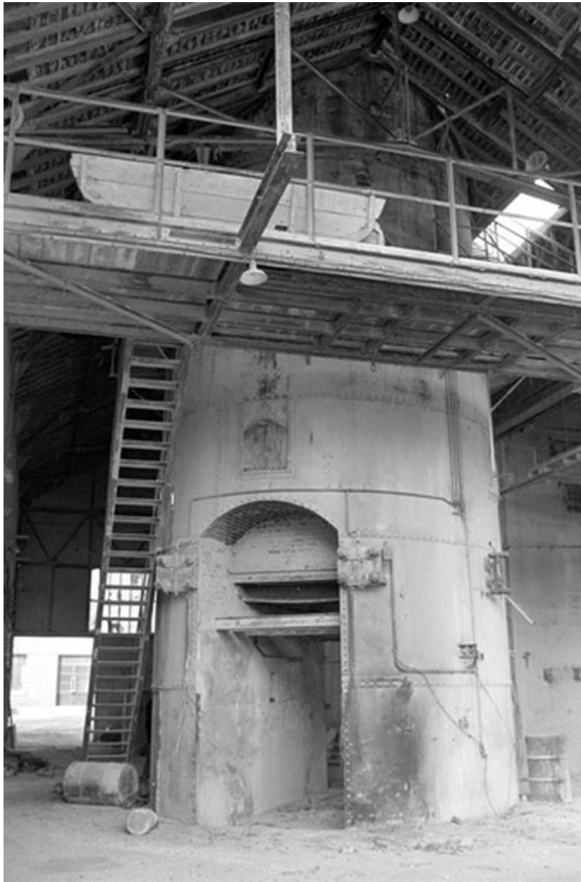
Four à chaux, vue intérieure.
