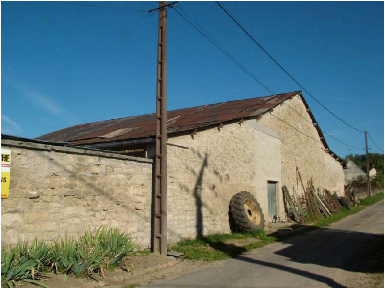
Vue de la grange.
