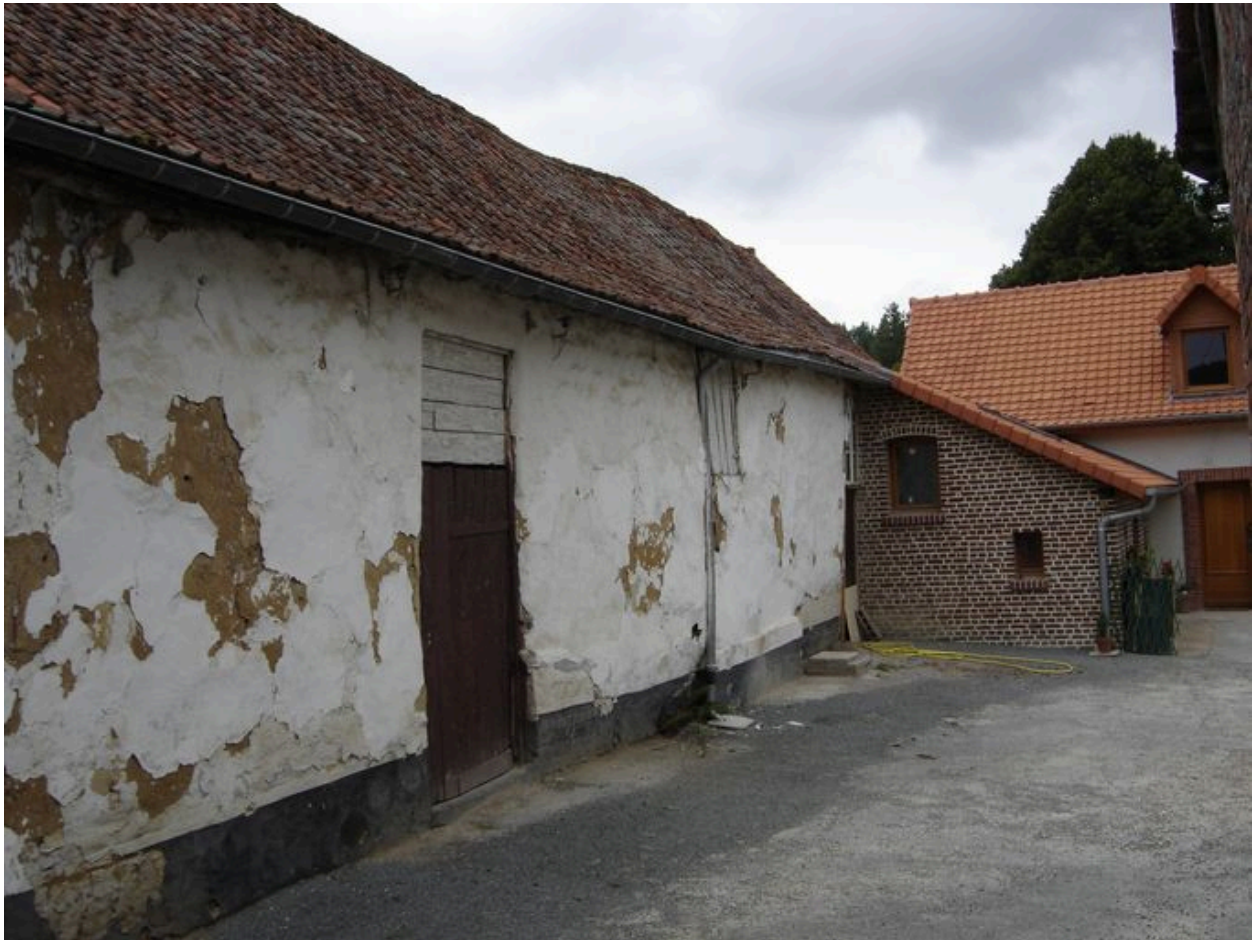
Vue du mur sur cour de la grange.
