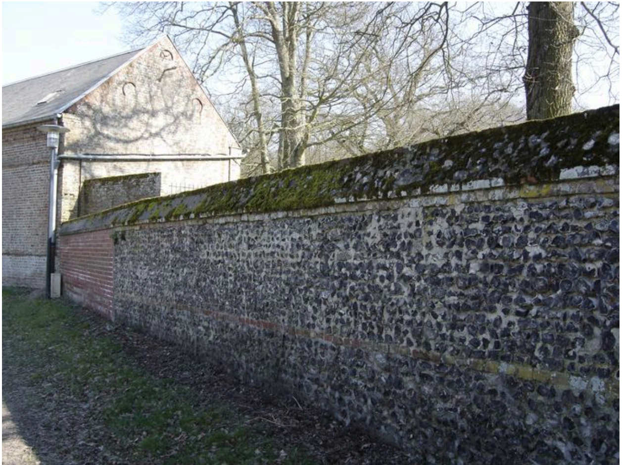
Vue du mur de clôture sur la rue du 8 Mai.
