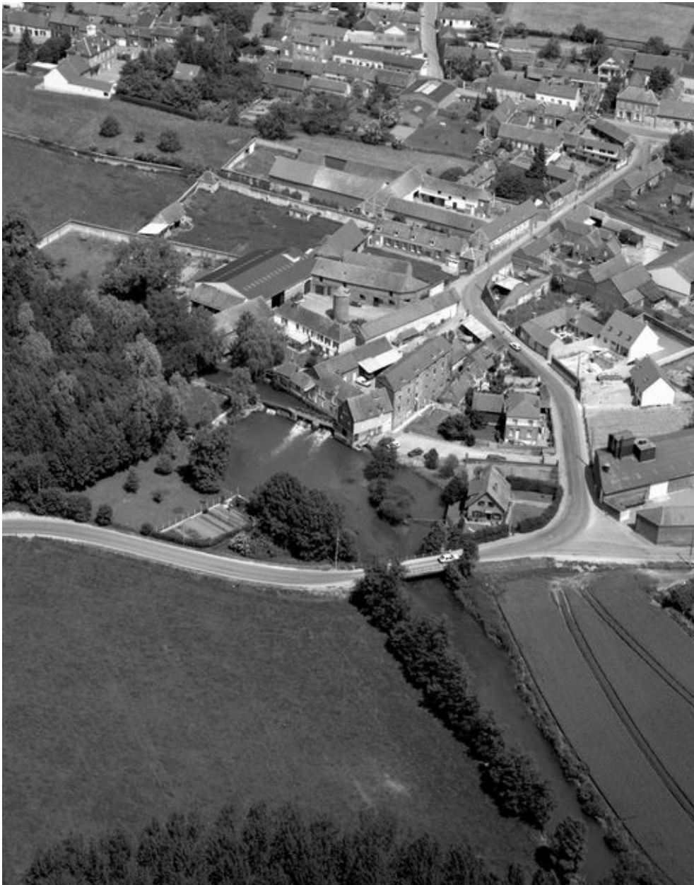
Vue aérienne de l'usine en 1994.
