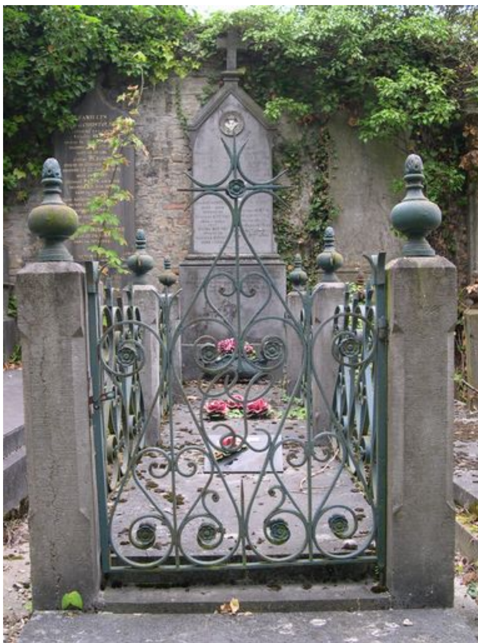
Vue de la clôture.
