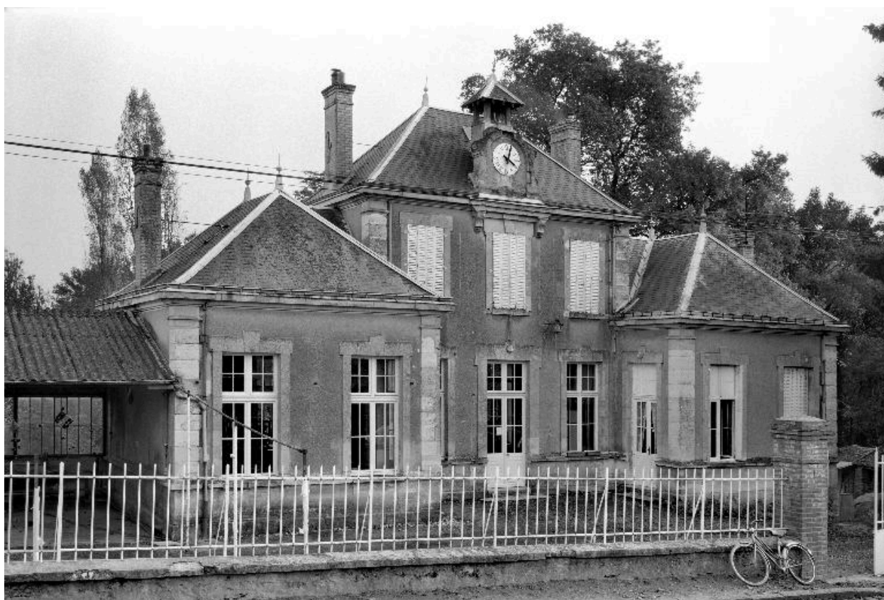
Vue générale de la façade.
