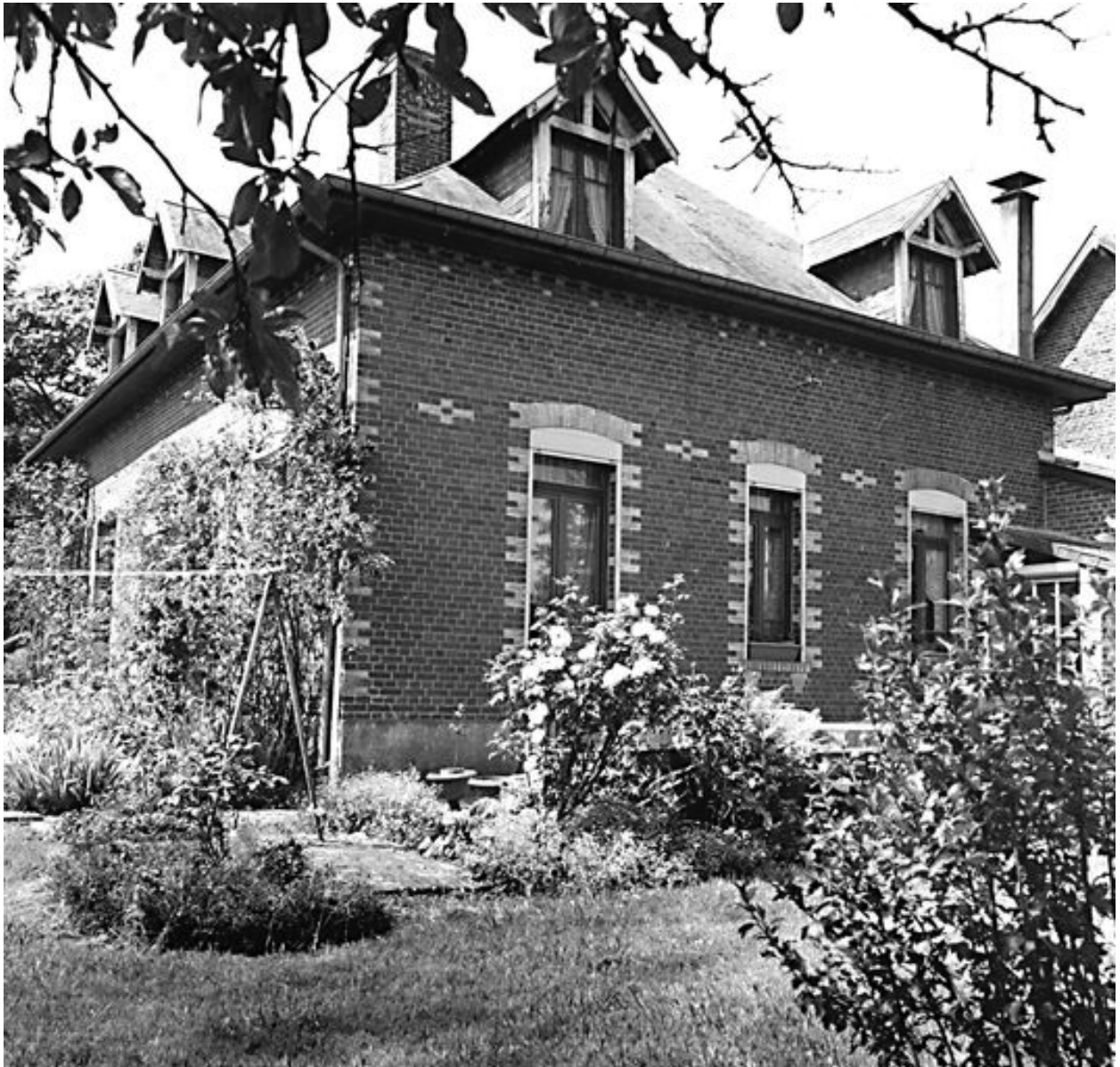
Élévation postérieure du logis de 1927.
