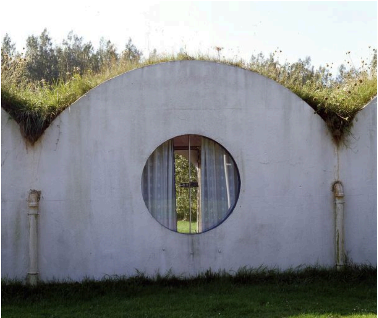
Détail d'un bungalow, élévation postérieure.
