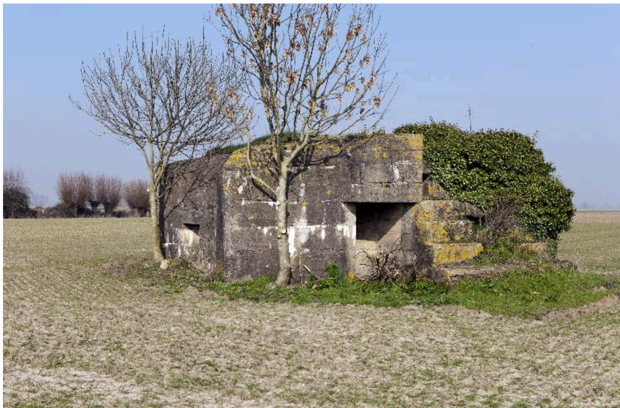
Vue générale vers le nord-est
