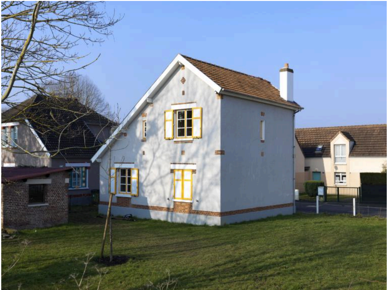
Maison. Rue des Tilleuls.
