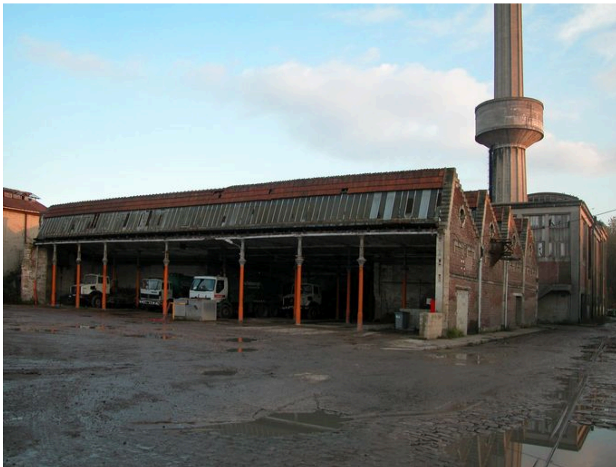
Vue des ateliers de tissage en shed et de la chaufferie à l'arrière
