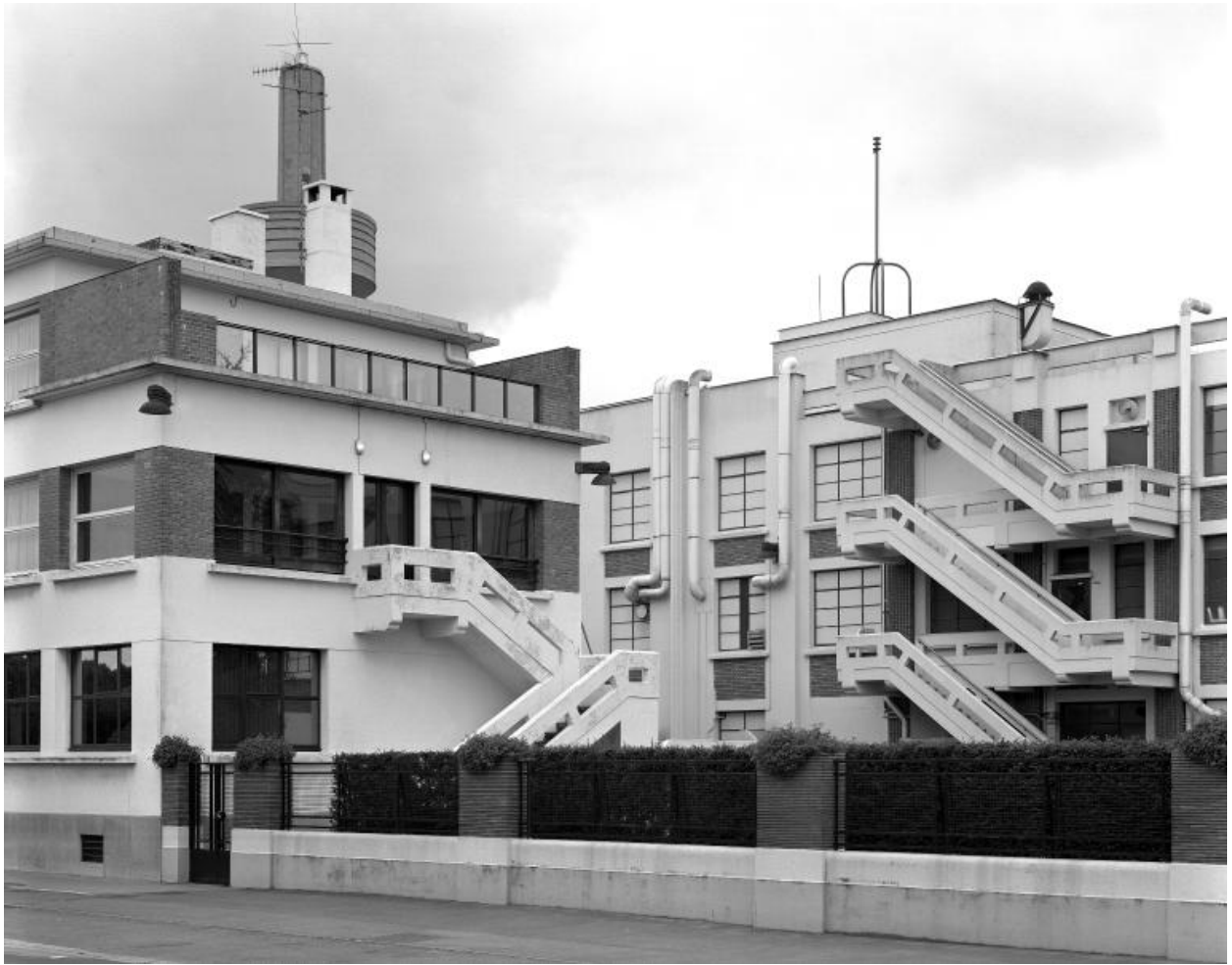
Les escaliers de distribution extérieurs des bureaux et de l'atelier de fabrication, vers le sud-est.
