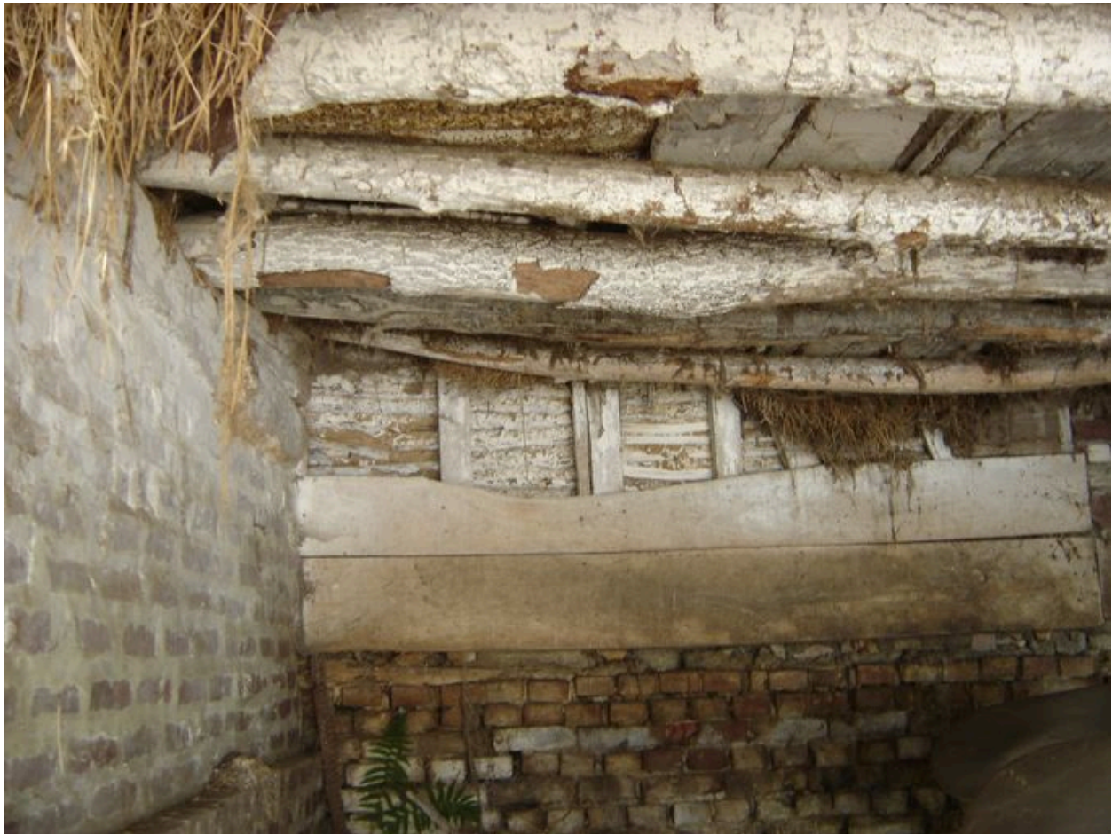
Vue détaillée du plafond.
