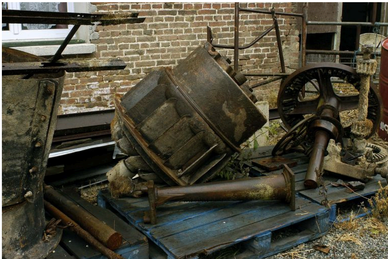
Vue d'ensemble de la turbine démontée.
