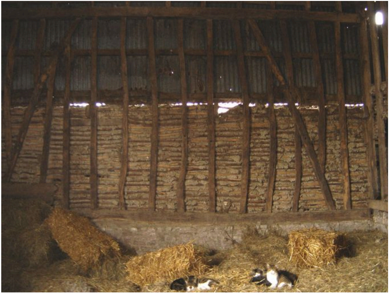
Vue intérieure de la grange.
