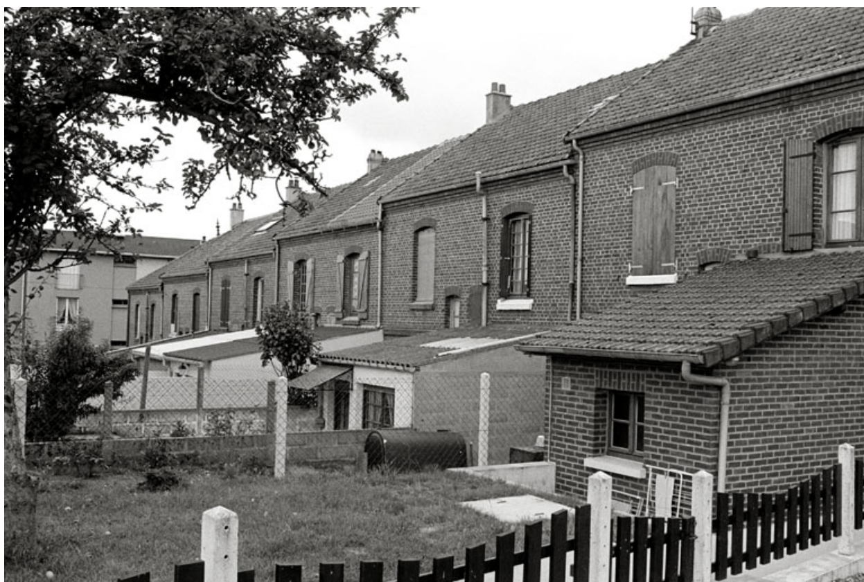
Logement d'ouvrier, rue René-Lefèvre, élévation postérieure.
