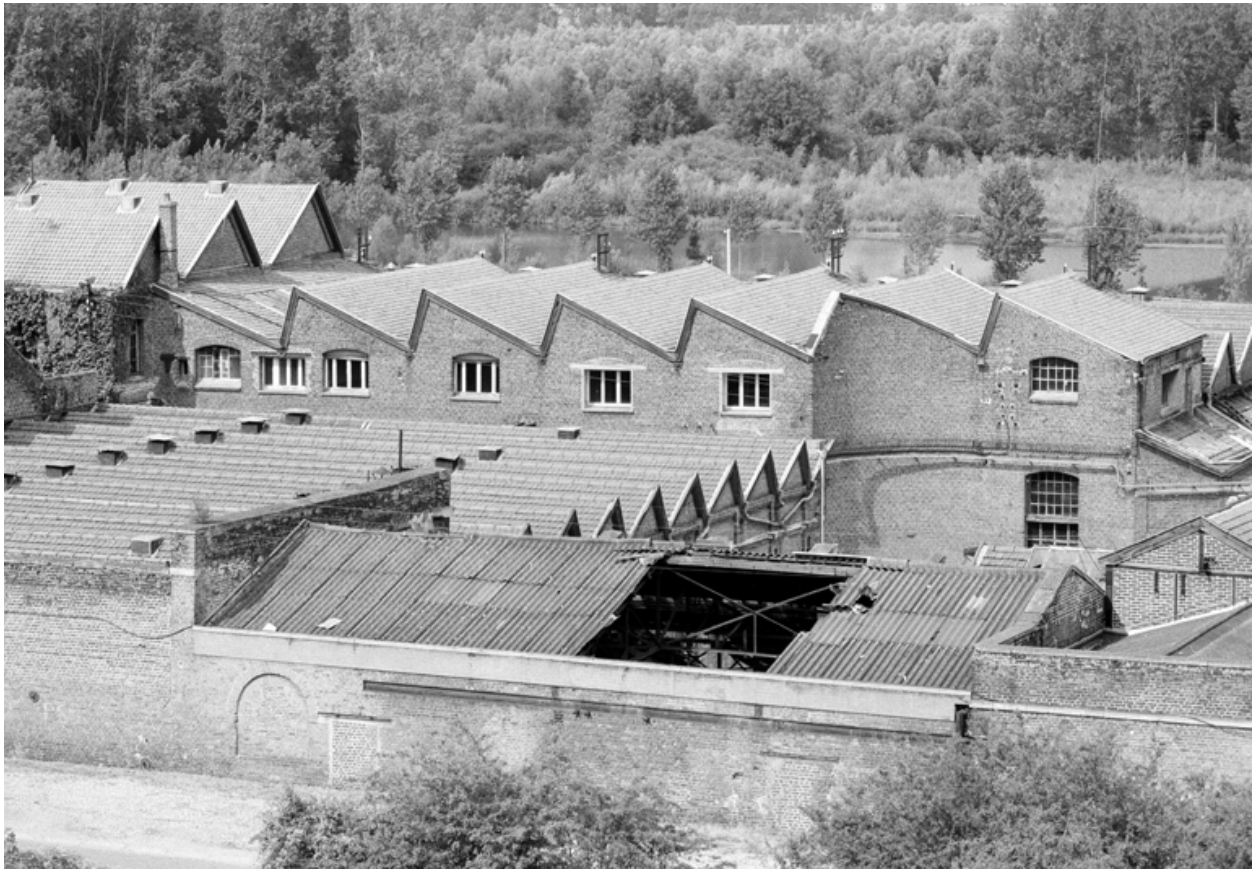
Vue partielle. Partie centrale.
