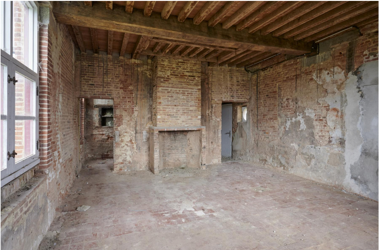
Rez-de-chaussée. Salle principale du logis du XVIe siècle. Vue vers le réduit, l'entrée principale et la cheminée.
