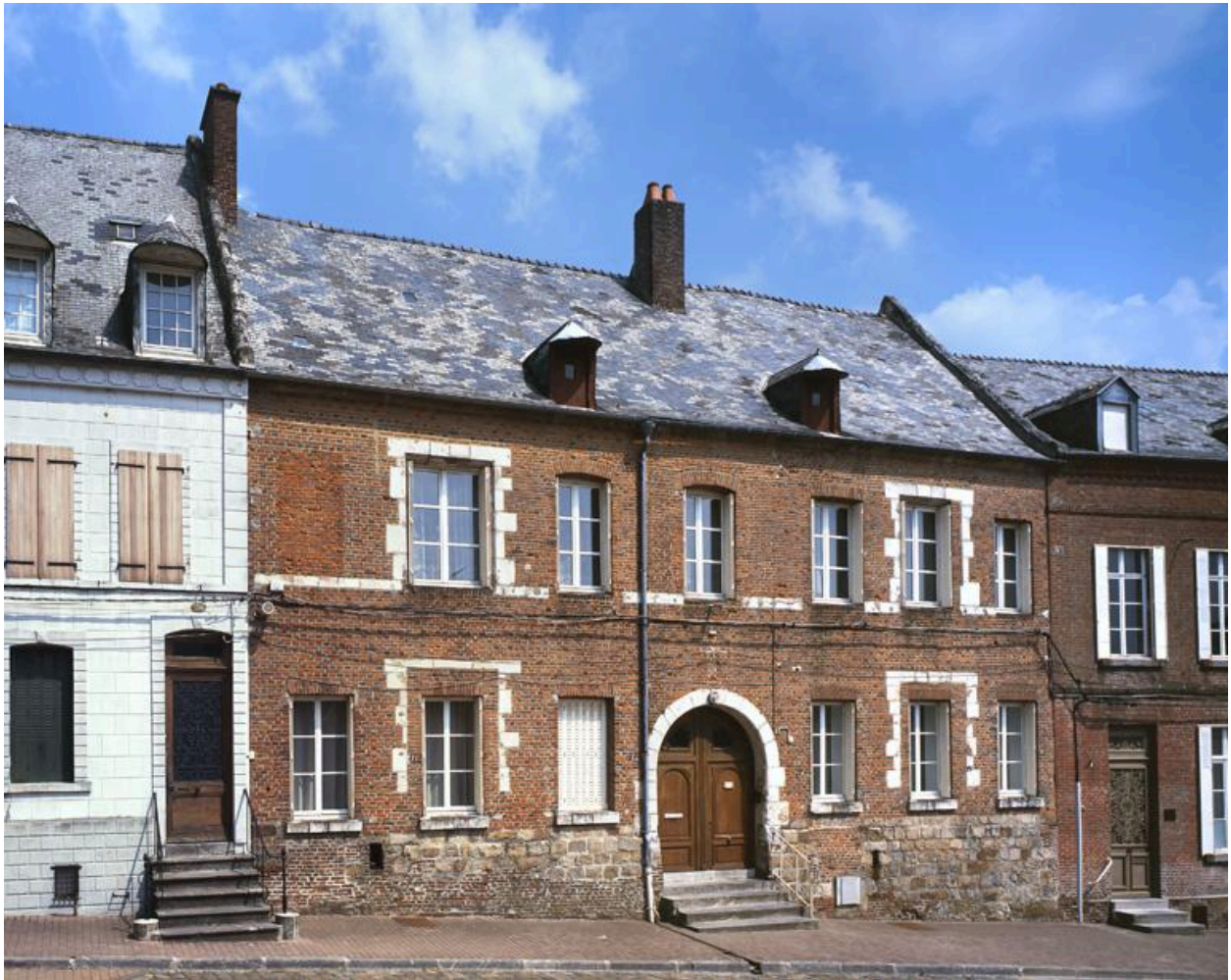
Vue de la façade, depuis la rue de l'église.
