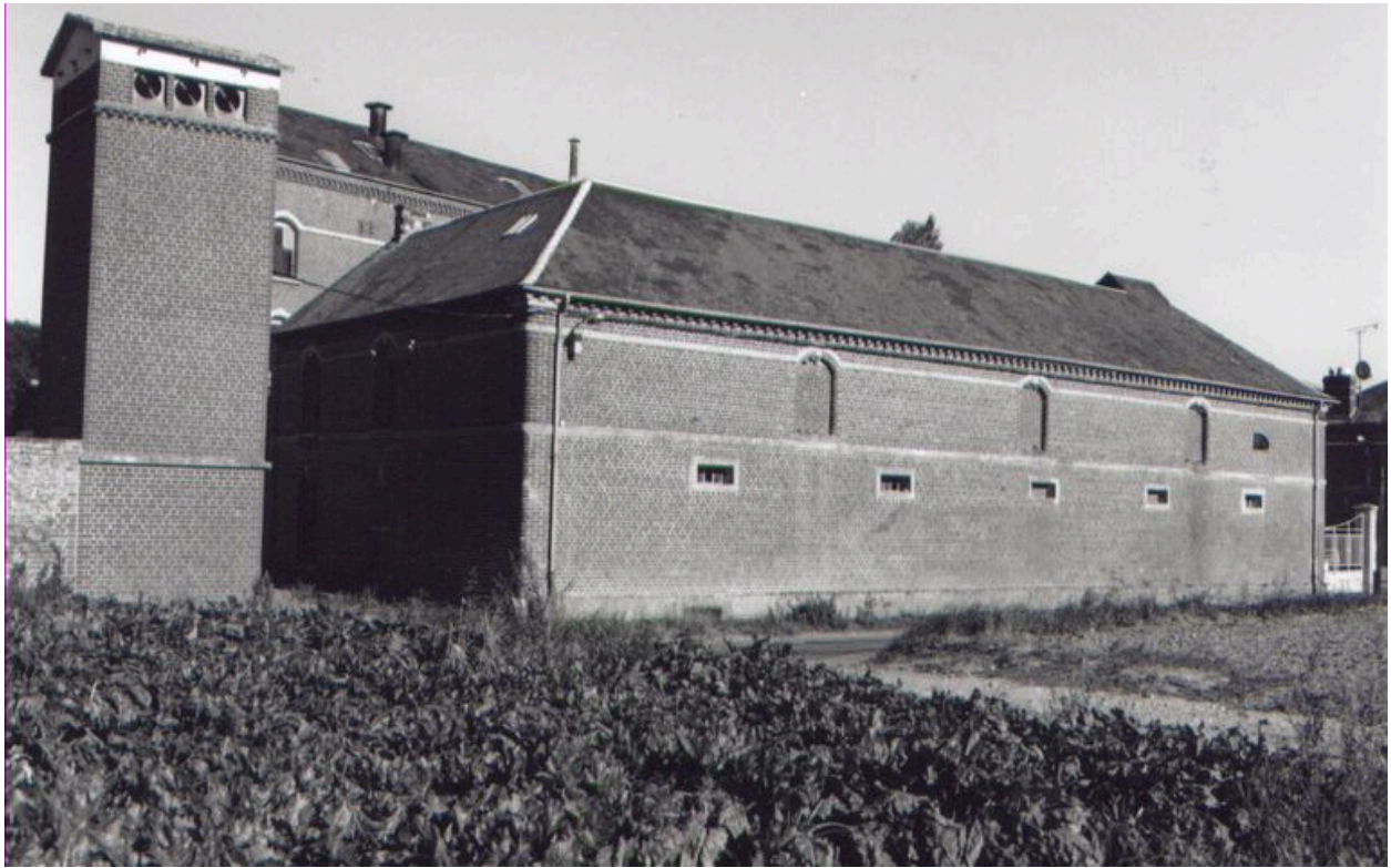
Façade sur rue de l'entrepôt industriel et du logement de meunier en retour.
