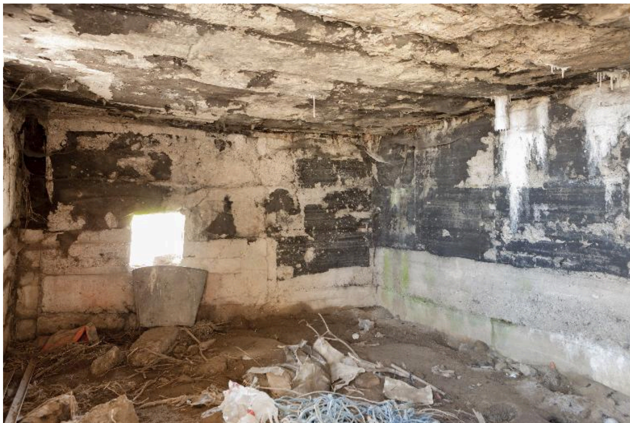
Bâtiment 4, vue intérieure
