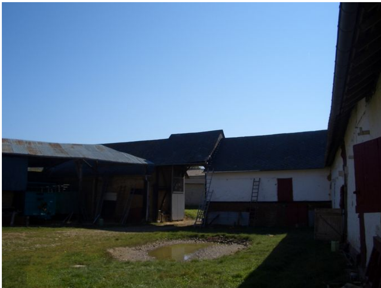
Vue depuis la cour du passage couvert flanqué des deux granges.
