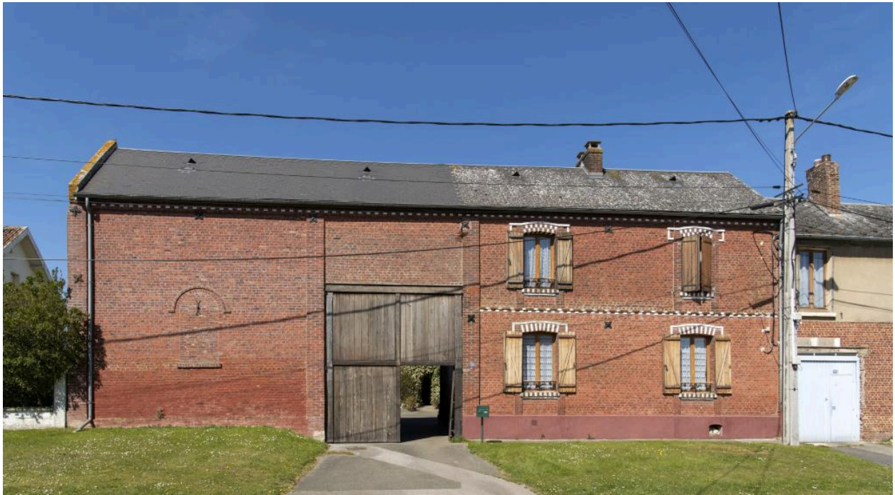
Logis, passage charretier et grange sur rue, n°30 rue Principale, vue depuis l'est.
