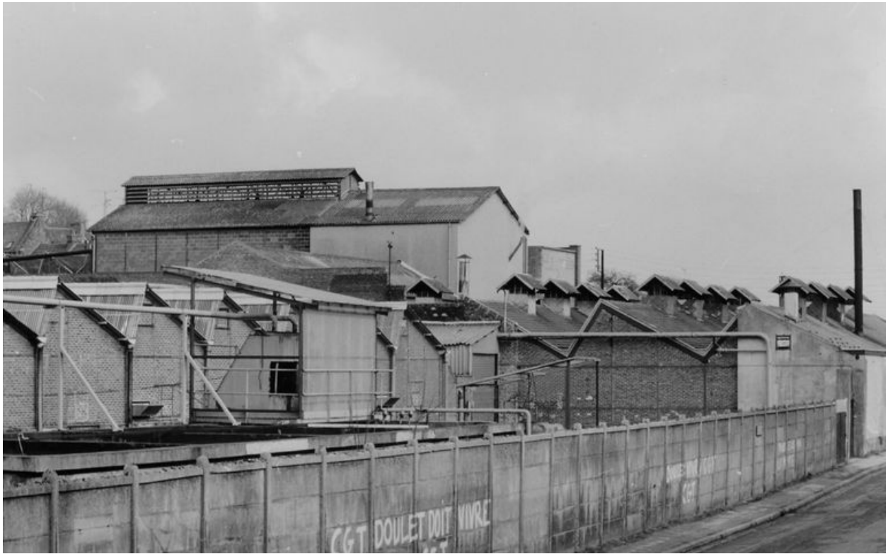
Les ateliers de teinture et les salles des machines, vus depuis le sud-ouest.
