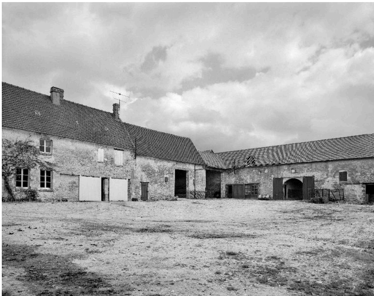
Vue des bâtiments qui forment l'angle est de la ferme : élévations sur cour.
