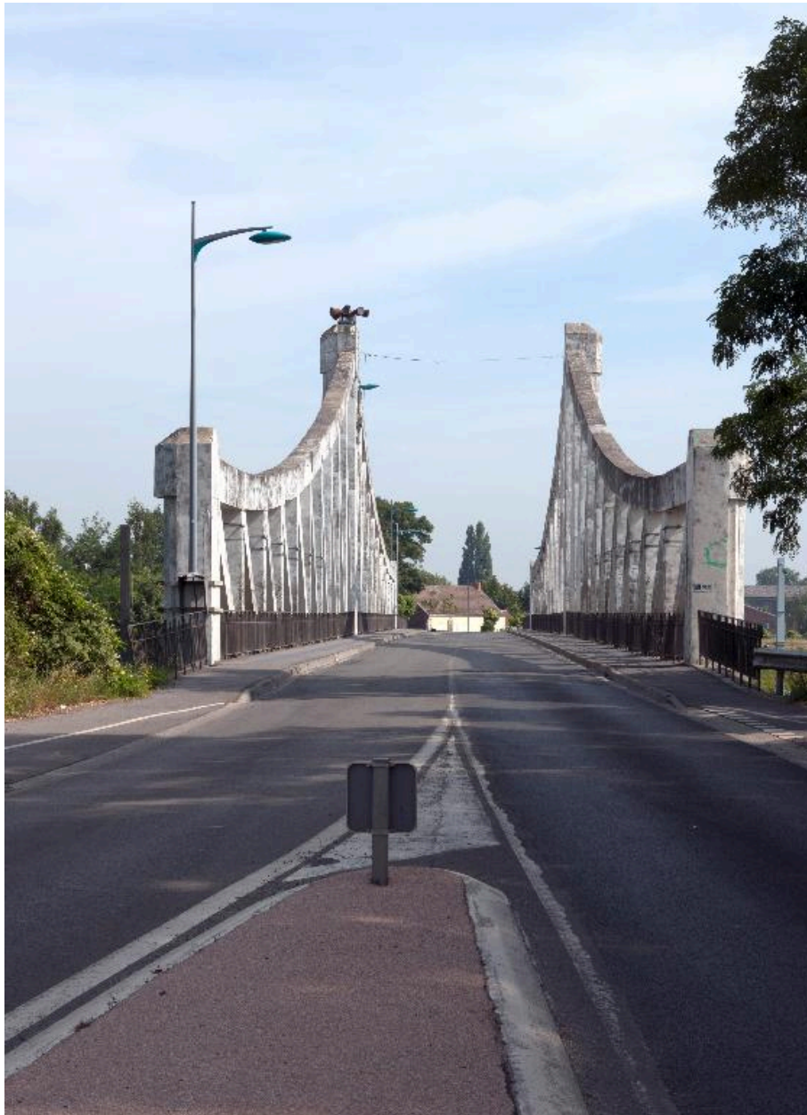
Vue de face du pont de chemin de fer.
