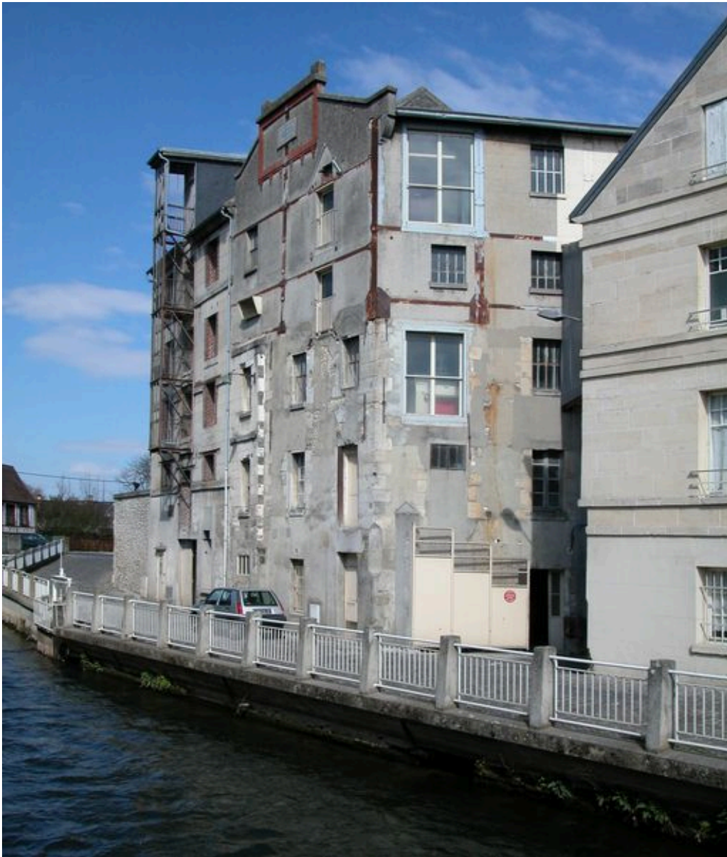
Vue d'ensemble du bâtiment d'entrée de la minoterie.
