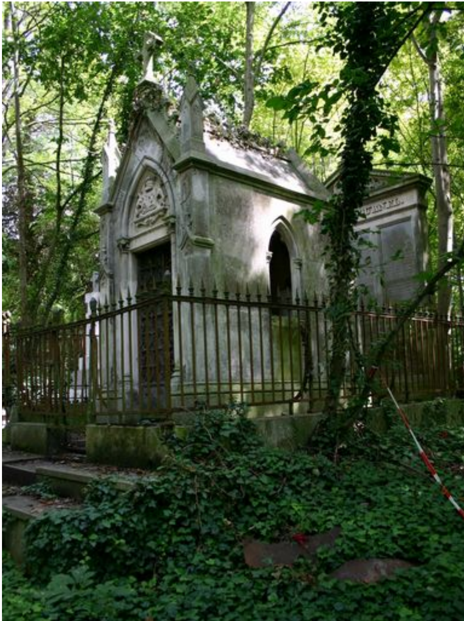
Vue générale, depuis le côté droit.
