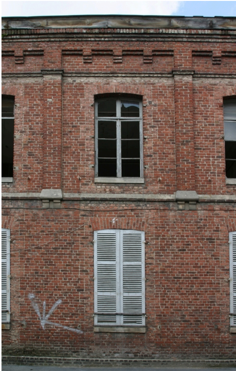
Les ateliers bordant la rue Richard-Lenoir construits en 1887 : détail d'une travée.
